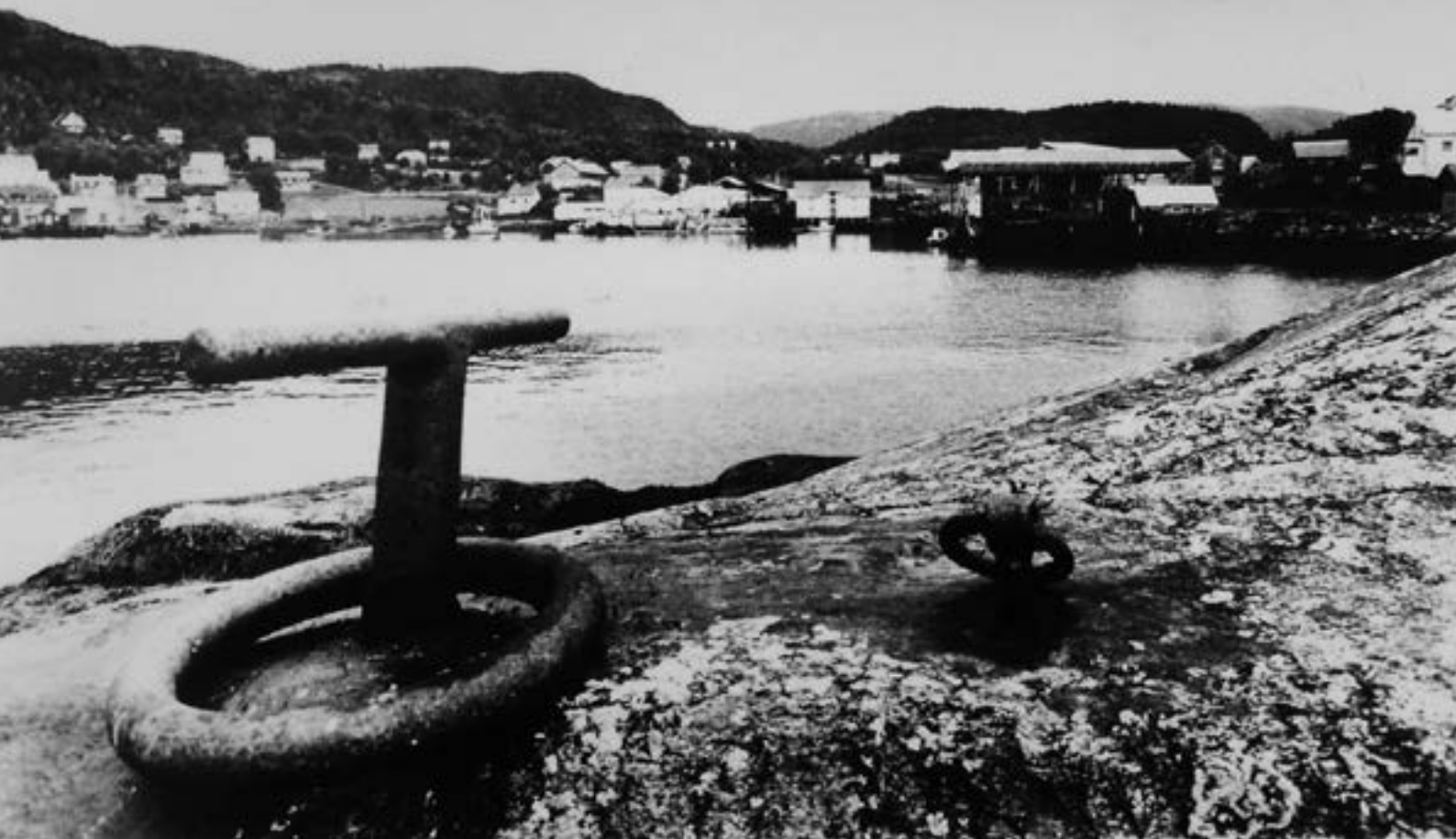
Fortøyningsring på Notholmen. Foto: Arbeider-Avisa 1976.
