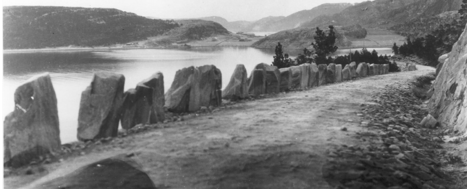
Buktakken, endel av det nye veianlegget Fevågskaret – Mælan i 1922. Til venstre ses Frevangsbukta og i bakgrunn ses Gangstøa og Selnes. Legg merke til stabbesteinene. - Foto: Johan A. N. Selnes, arkiv nr. 234.
